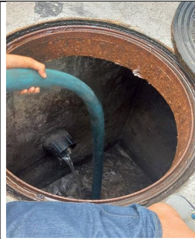
รูปที่ 2-21 การสูบน้ำจากระบบบำบัดน้ำเสียโดยเอกชน
