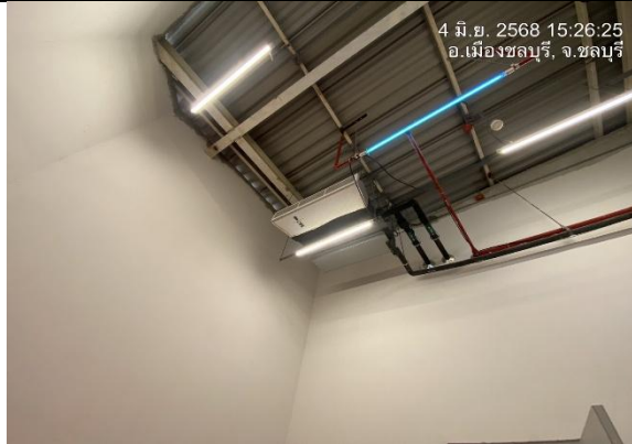
รูปที่ 2-17 การติดตั้งเครื่องปรับอากาศในห้องพักมูลฝอยติดเชื้อ
