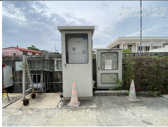
รูปที่ 2-20 มาตรการไฟฟ้าของระบบบำบัดน้ำเสียที่แยกจากมาตรไฟฟ้ารวม
